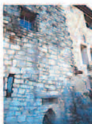
Jonction avec la façade secondaire du bâtiment voisin (B 3547)
