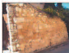
Mur de clôture de la cour
